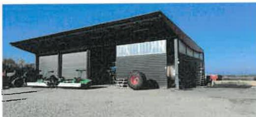
Ce bâtiment a été construit en 2006. D'une surface de 297 m<sup>2</sup>, il comprend un atelier, un espace de convivialité avec cuisine, des sanitaires, un espace de stockage, une mezzanine. C'est un bâtiment métallique couvert et bardé en bac acier, avec 3 portes sectionnelles et une porte coulissante de grande hauteur. Il est implanté sur la parcelle D1534 d'une surface de 4 001 m<sup>2</sup>.
